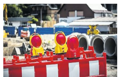
In Oberflockenbach beginnen heute Kanalbauarbeiten. SYMBOLBILD: PHILIPP REIMER
